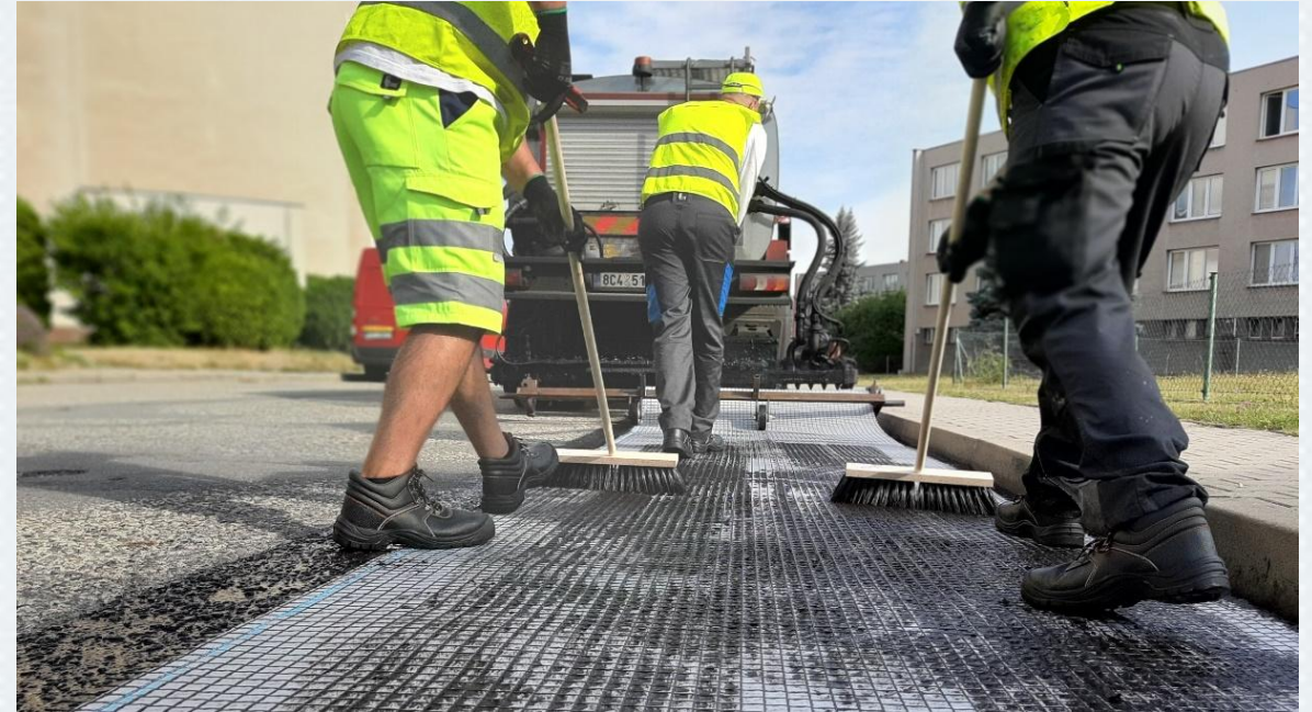
Aplikace geokompozitu do spojovacího postřiku
