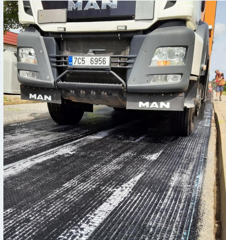
Zařízení na pokládku EMK pojíždí po instalovaném geokompozitu
