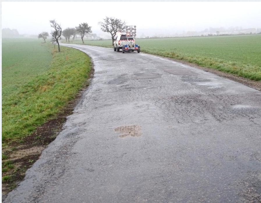
Původní stav vozovky (11/2020)
