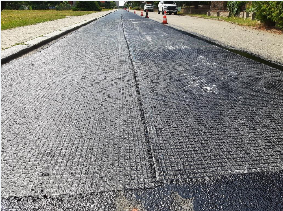
Instalovaný geokompozit s ultralehkou geotextilií
