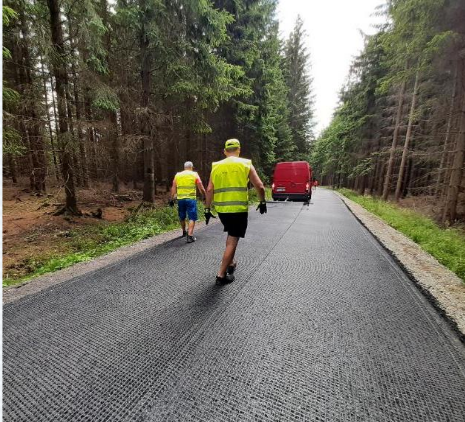
Celoplošná instalace samoadhezních sklovláknitých geomříží
