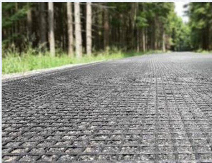
Detail na instalovanou geomříž
