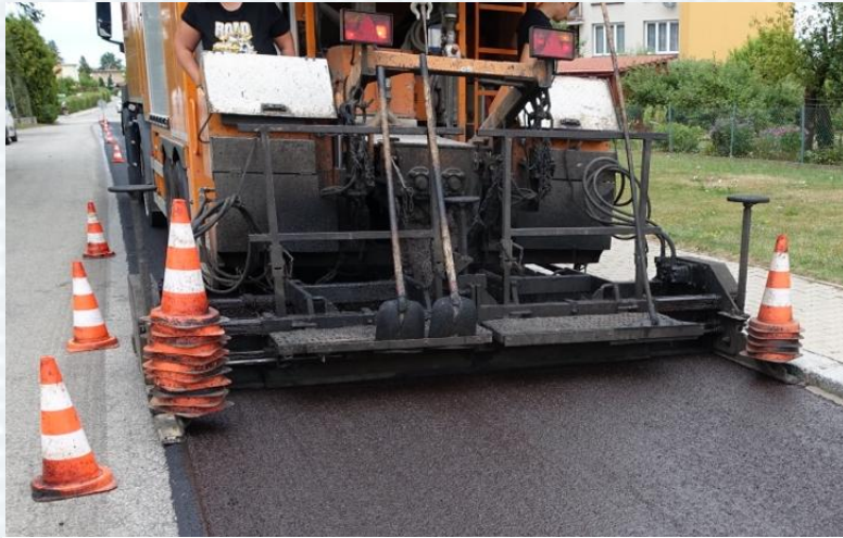
Položená vrstva EMK na geokompozitu
