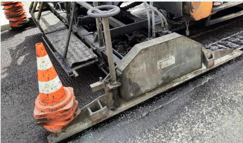
Kladecí rám zařízení pro pokládku EMK
