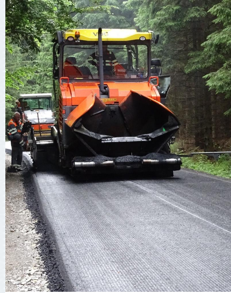
Pokládka obrusné vrstvy na geomříž
