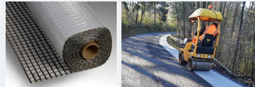
Geokompozit GCO-B a jeho instalace
