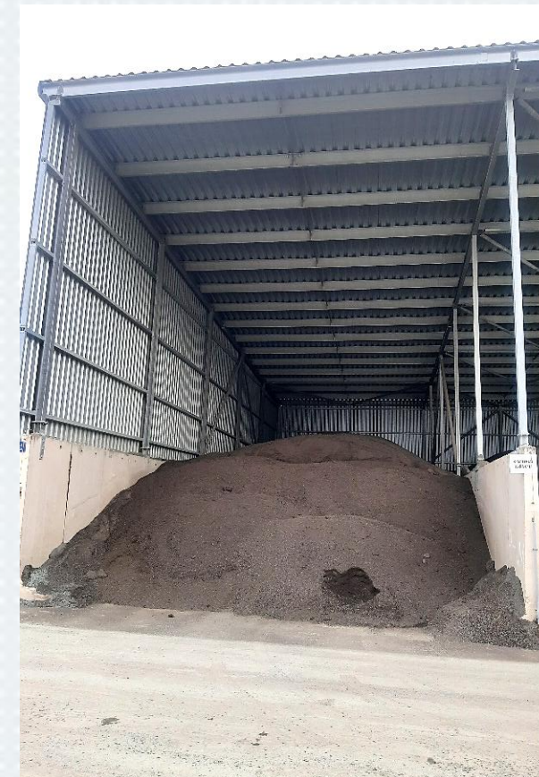
Zastřešená skládka R-materiálu na obalovně v Rajhradících
